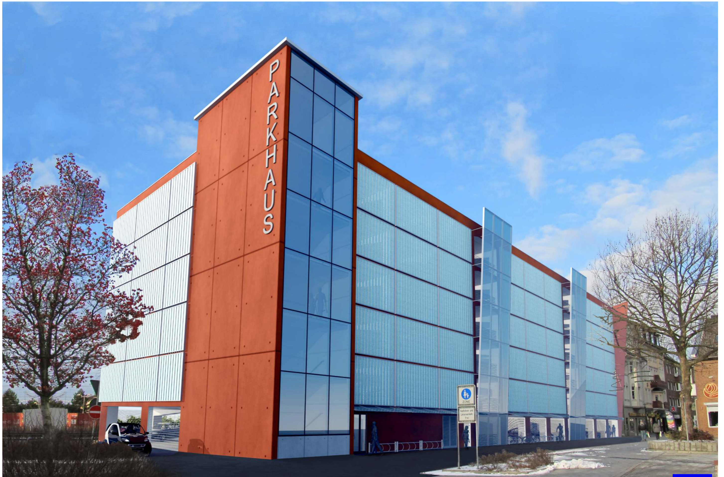
NEUBAU PARKHAUS POSTSTRASSE • PROFILITFASSADE • LEHRTE
